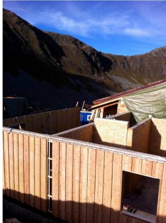
Errichtung des Anbaus
