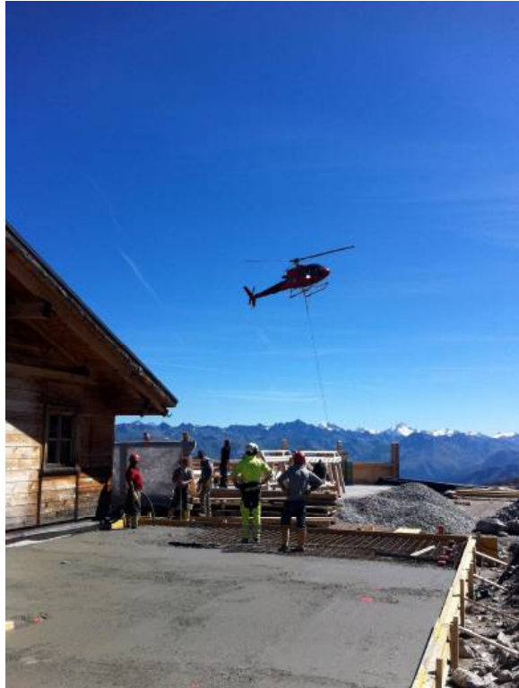
Hubschraubertransport für Fundamentplatte
