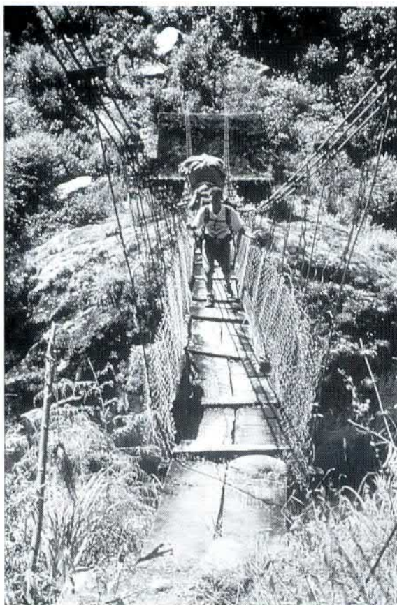
Brücke über den Bhotse Kosi.
